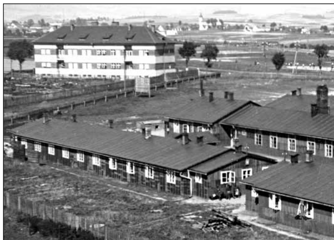
Bytový dům pro důstojníky z r. 1937 stojí vedle přízemních provi-zorních domků, tzv. likusáků.
