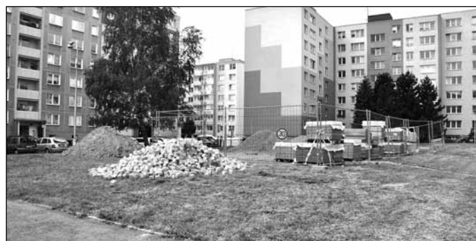
Město uvolní další prostředky z rozpočtu města, aby zhotovitel revitalizace sídliště Dolní provedl co nejvíce stavebních úprav ještě v letošním roce.
