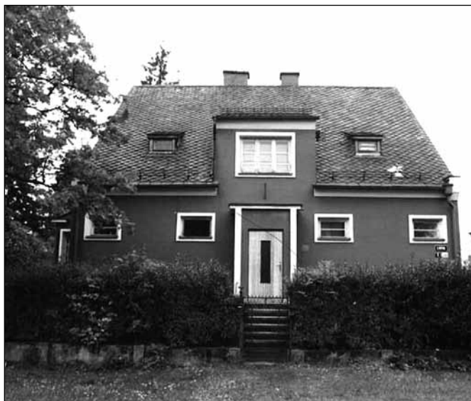
Dům Hosových – pohled ze směru od Rýmařovské ulice.
