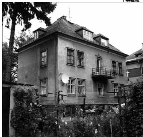
Dům p. Czerwenkové – pohled z ulice 9. května.
