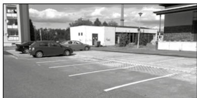
Nová parkovací místa vznikla zrušením travnatého pozemku za Lesankou. Foto: archiv
