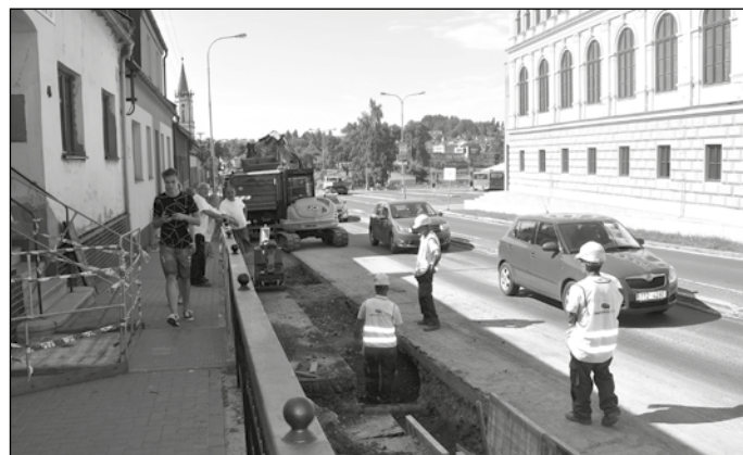
Stavební práce v centru Bruntálu pokračují. Ještě několik týdnů se musí chodci i řidiči obrátit trpělivostí. Rekonstrukce plynovodu a plynovodních přípojek na ulici Dr. E. Beneše by měla trvat do konce srpna. Koncem září by měly skončit i práce na ulici Požárnicků, Kavalcova a Pionýrská. Foto: zup
