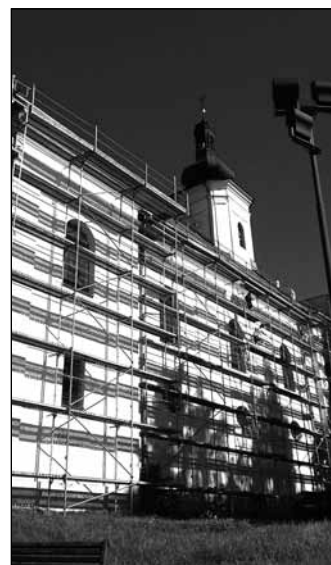
Kostel na Uhlířském vrchu dostává část nové střechy. Oprava si vyžádá necelý milion korun.
