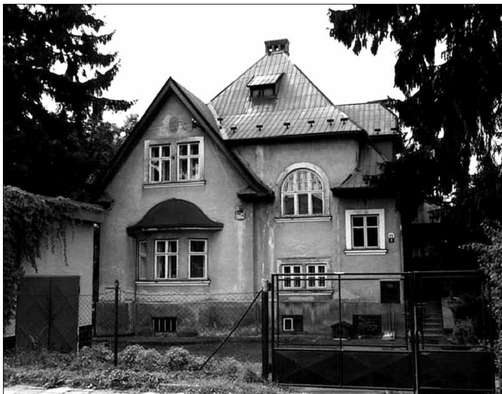
Dům Roberta Mildnera, Husova ulice – ještě v původní barevnosti, před opravou.
