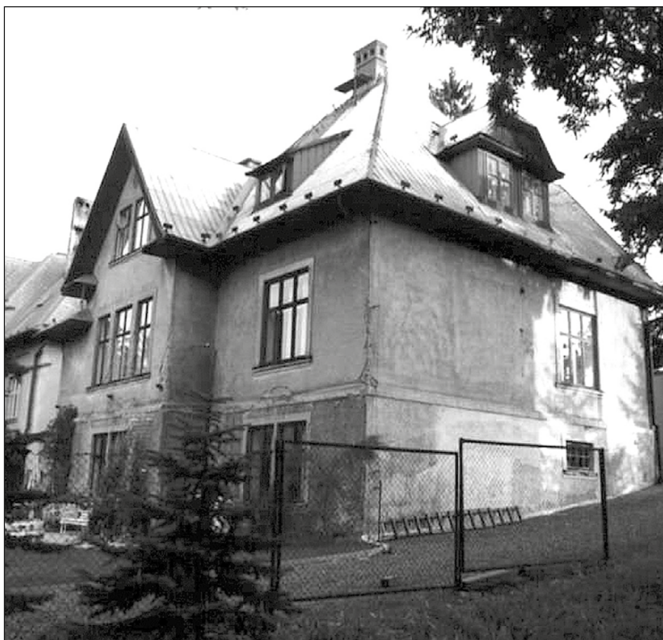
Dům Roberta Mildnera, Husova ulice – zahradní průčelí před opravou.
