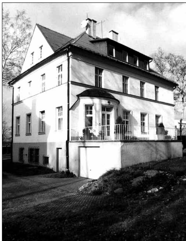
Vila Wilhelma Macholda – zahradní průčelí.
