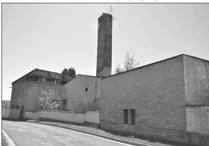
Také části areálu ve Fügnerově ulici jsou postupně rozebírány.
