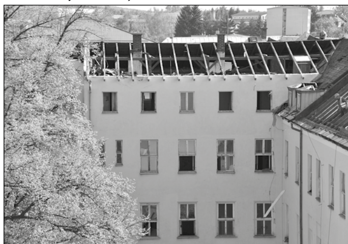
Práce na budově jsou od května v plném proudu.
