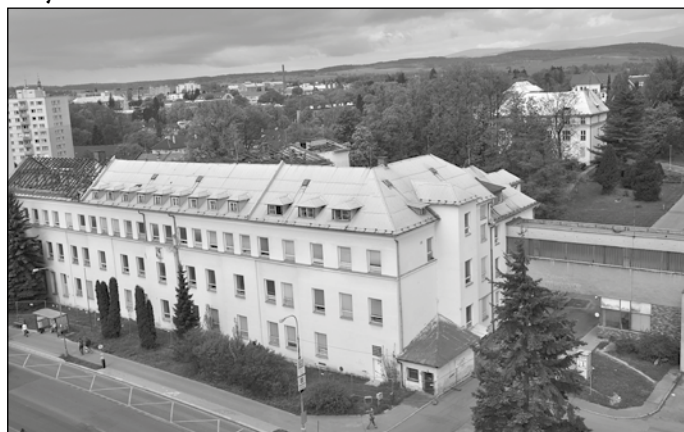
Demolice objektů v nevyužívané části nemocnice.
