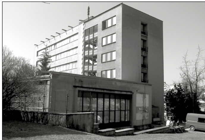
Budova městského úřadu před začátkem prací.
