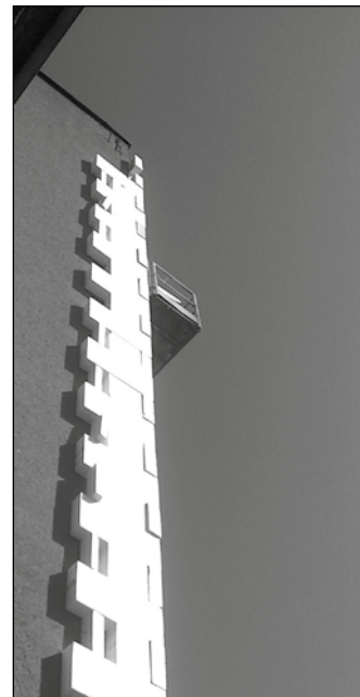
Kompletní zateplení a také výměna oken by měly být hotovy do konce letošního července.
