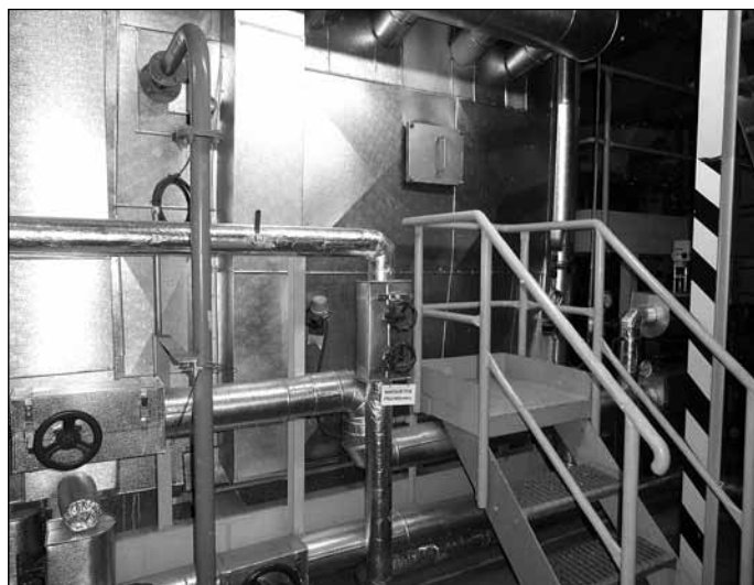
Rekonstrukce uhelné výtopny v Dolní ulici v Bruntále.
