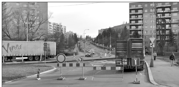
V současnosti jsou práce soustředěny do ulic Dukelské a Nádražní. Foto: lc
