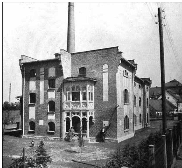
Nádherná secesní budova elektrárny, zůstal jen trpaslík.
