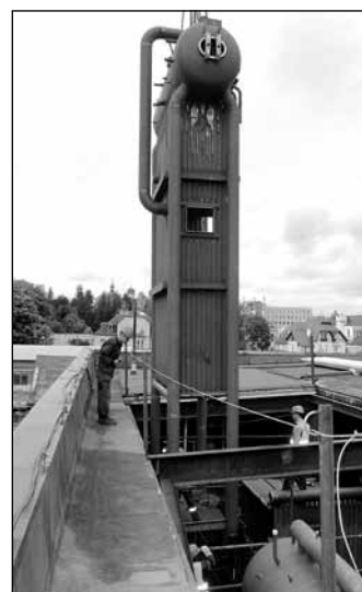
Instalace nových kotlů na CV Dolní v Bruntále byla v říjnu dokončena. Foto: LT
