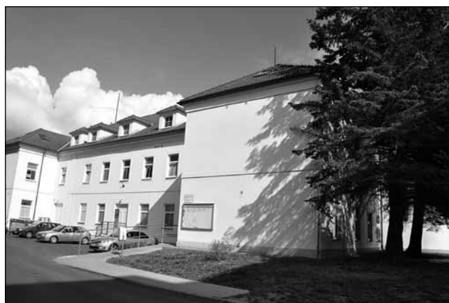
Severní část původního nádvoří chudobince a špitálu.
