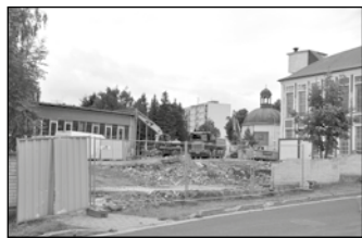
Demolice areálu ve Fügnerově ulici.
