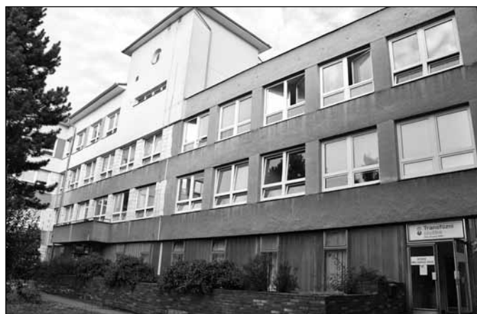
Vstup do pravého křídla nemocnice – Transfúzní stanice.
