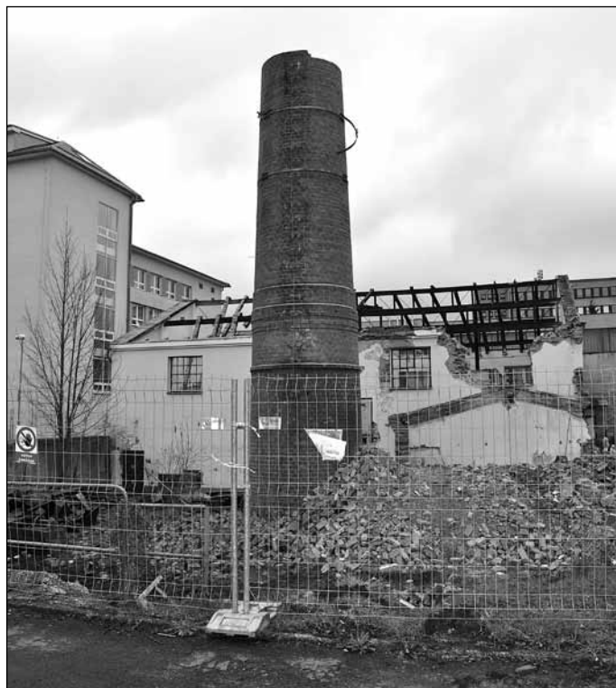
Bourání objektu kotelny z 20. let 20. století.
