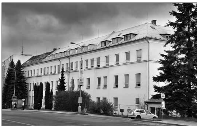
Bývalá hlavní budova nemocnice v první polovině roku 2015.
