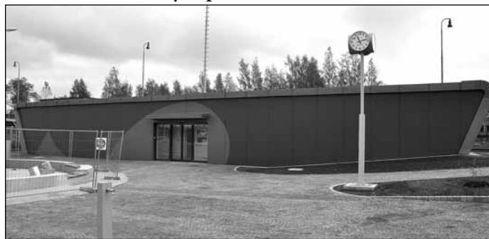
Nové veřejné WC v rámci stavby dopravního terminálu v Bruntále zahájilo provoz první lednové pondělí. Foto: archiv
