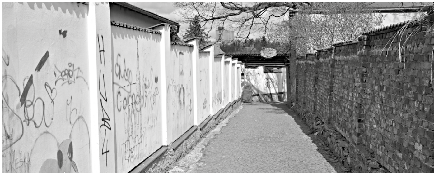
Farní uličku v centru města čekají velké opravy. Zbrusu nový bude povrch a do budoucna se počítá i s osvětlením uličky.
