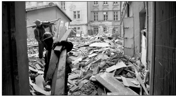
Nádvoří se stalo dočasným skladištěm.
