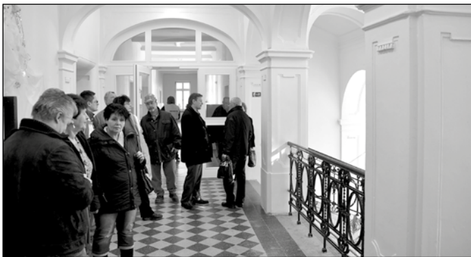
Opravy zatím pokračují dobře. V současné době už má polovina budovy opravené interiéry a ve druhé části jsou práce v plném proudu.
