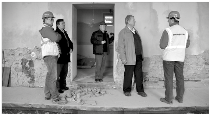
Pravidelně se konají kontrolní dny, při nich je monitorován průběh dosavadních stavebních prací.
