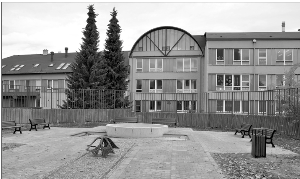
Základní škola v Cihelní ulici.
