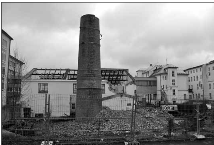
Demolice nefunkční kotelny v areálu bruntálské nemocnice byla dokončena letos. Foto: lc
