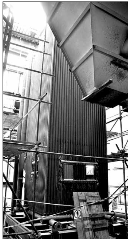
První fáze rekonstrukce uhelné výtopny na CV Dolní v Bruntále se blíží ke konci. Další fáze oprav bude pokračovat v následujícím roce. Foto: lc
