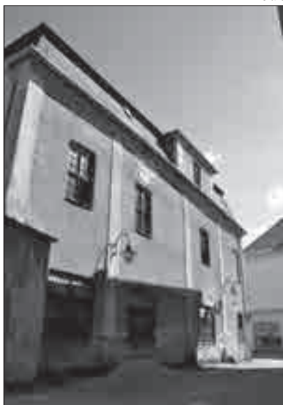
Budova před rekonstrukcí.
