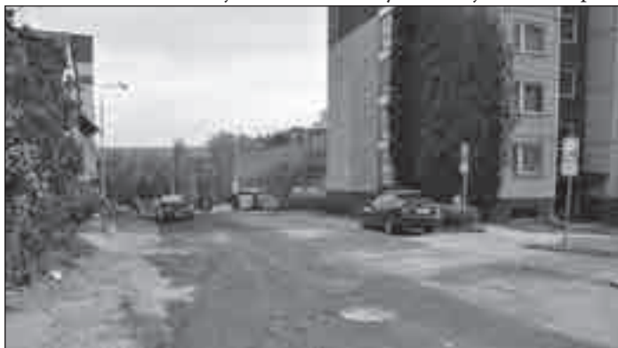
Rekonstrukce ulice Okružní a Na Kopečku by měla být kompletně dokončena v polovině příštího roku. Foto: lc
