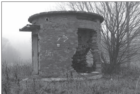
Stavba nad vrtem.
