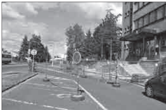
Rekonstrukce hlavního vstupu do budovy městského úřadu byla zahájena 15. srpna, trvat by měla celkem tři měsíce. Foto: lc
