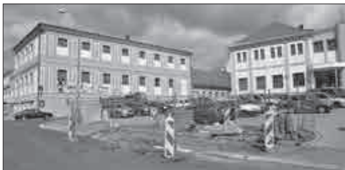
Rekonstrukce kanalizace v úseku od křižovatky Partyzánské ulice po křižovatku ulice Květná probíhá od srpna. Součástí bude také rekonstrukce vodovodního řadu a úprava komunikace včetně přílehlých chodníků.
