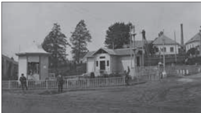
Výstavba výstaviště v Květné ulici – prostor budoucí vstupní brány, zleva – strojní hala, altán parní pily Maxe Berla, dům Roberta Mildnera.
