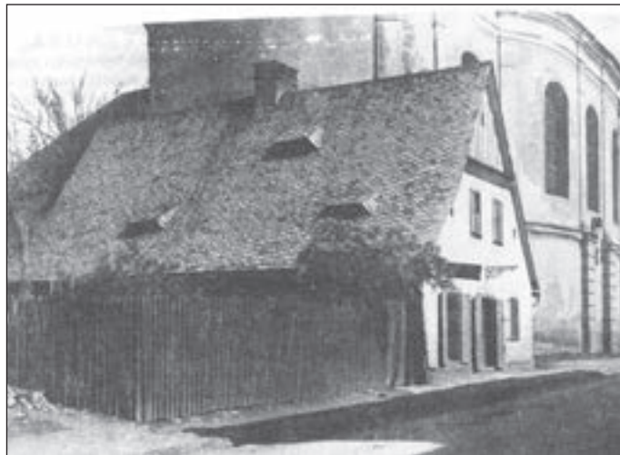
Dům stojící na místě dvora dnešního gymnázia.
