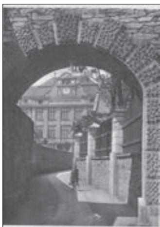
Pohled na budovu gymnázia z dnešní Slezské uličky.
