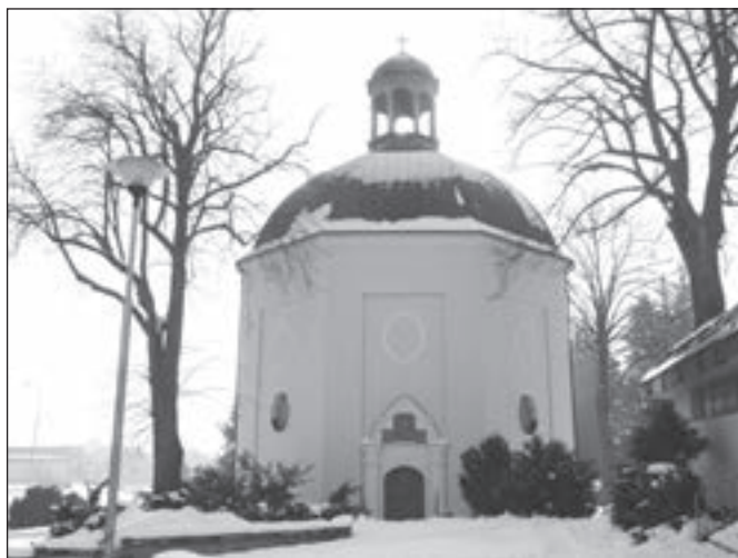
Kaple po poslední opravě.
