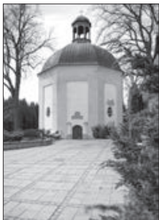
Hřbitovní kaple sv. archanděla Michaela před poslední opravou.
