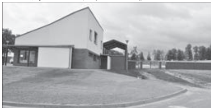
Dokončení stavby provozní budovy na pohřebišti na Uhlířském vrchu bylo oficiálně potvrzeno předáním. Foto: lc
