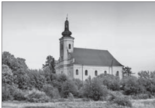
Kostel před opravou.
