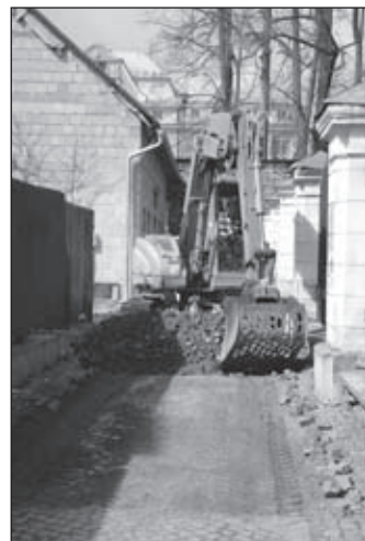
Kvůli opravě je ulička dočasně uzavřena.
