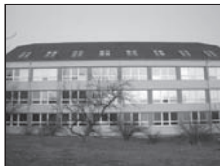
Hotová část školy po výměně oken a zateplení. Foto: -dd-
