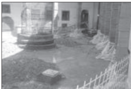
Opravy začaly na jaře a dokončeny by měly být na konci letošního roku.
