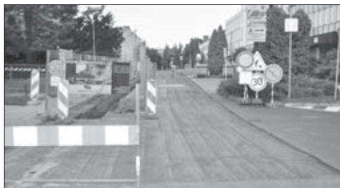
Opravy v Partyzánské ulici jsou v plném proudu. Měly by, podle plánu, být hotové v průběhu listopadu.
