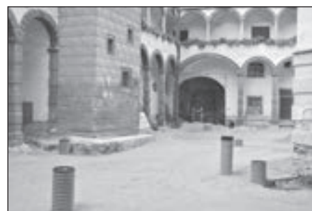
V září byl patrný posun v pracích. Co nevidět začne pokládání dlažby.
