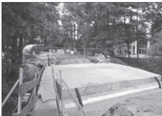
Most v Kavalcově ulici je kvůli opravám uzavřen.
