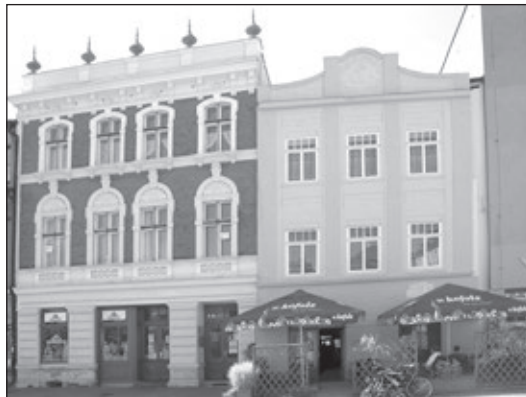
Opravy domu č.p. 11 (vlevo), který je zároveň bruntálskou kulturní památkou, začaly už před jedenácti lety. Výsledek ovšem stojí za to, budova se dočkala renovace a náměstí zaslouženě zdobí.
