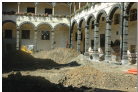
Nádvoří se začalo propadat, a tak nebylo nač čekat. Opravy začaly na jaře a dokončeny by měly být na konci letošního roku. Foto: lc
