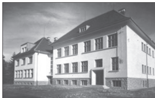
Budova české menšinové školy.
