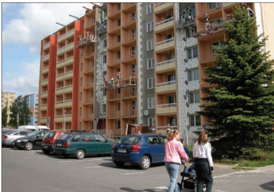
Opravy panelových domů v Bruntále zkrášlují dříve šedá sídliště. Majitelé nechávají domy zateplovat a fasády jsou malovány jemnými odstíny pastelových barev. Snímek je z ulice Dělnická a Cihelní.
