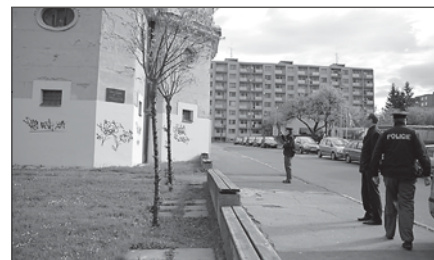
Sprejem poškozená fasáda školy.
