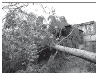
V Hálkově ulici spadlý strom poškodil zahradní chatku.
