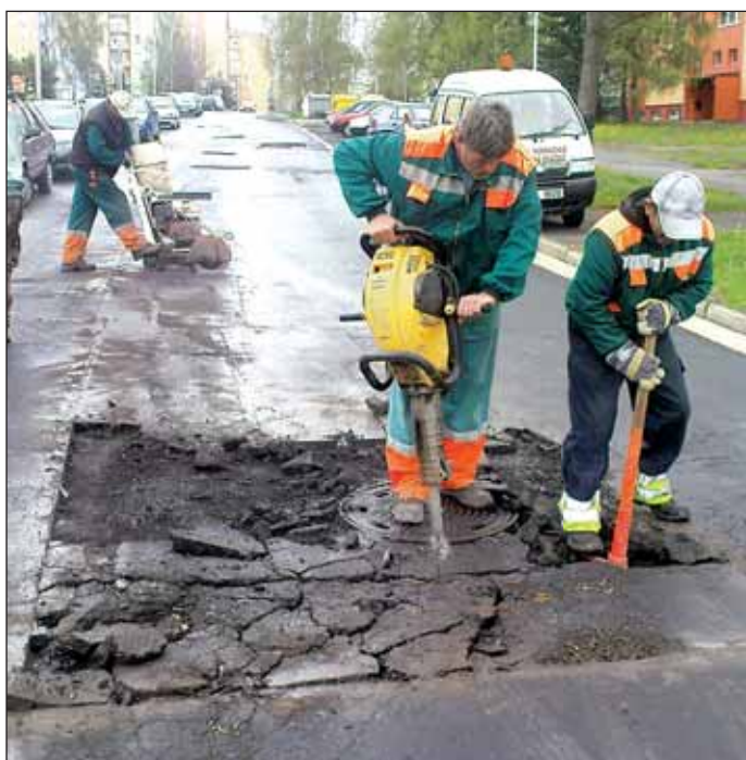
Mezi nejvíce rozbité ulice ve městě patří i Uhlířská, na které se v těchto dnech provádějí rozsáhlé opravy. Foto: TS Bruntál
