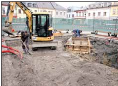
Budování fontány v centru města. Foto: - dd-
