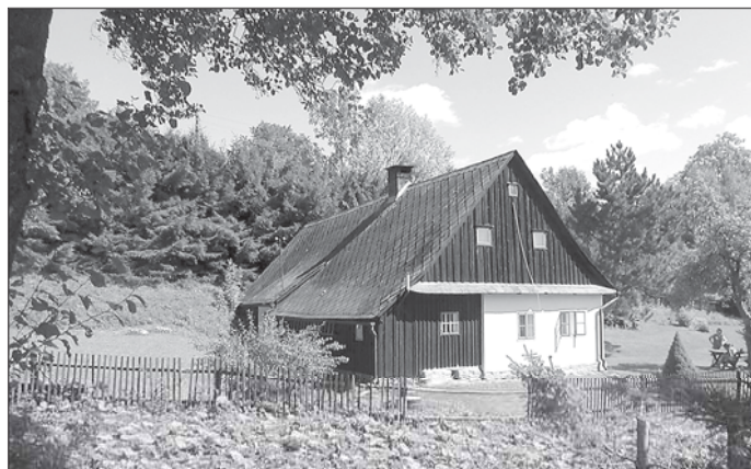
Jednotný dům s roubenou komorou a bedněnou chodbou.
