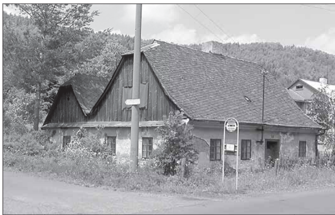
Dům v kožichu s výměnkem na okapové stěně.
