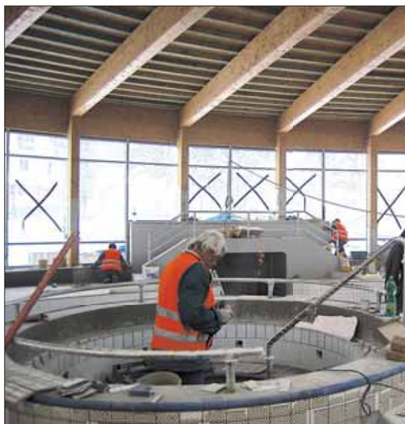
Rekonstrukce bazénu je před dokončením.
