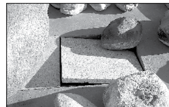
Příklad vandalismu: poškozená fontána na náměstí.
