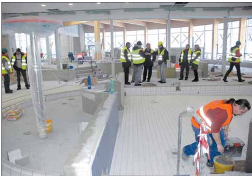
Rekonstrukce bazénu je před dokončením
