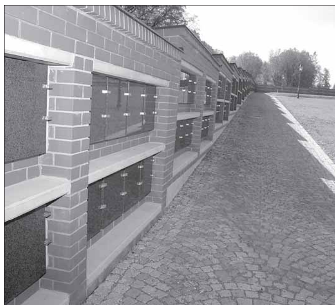
Kolumbárium pro uložení uren je zdobeno žulovými deskami.
