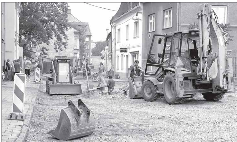
Ulice Požárníků prochází celkovou rekonstrukcí, včetně kanalizace. V první části se dokončují zemní práce a nyní začne oprava části směrem k ul. Dr. E. Beneše.
