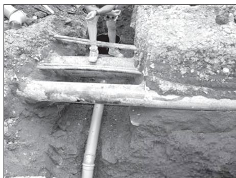
V ulici Požárníků se mění také kanalizace.
