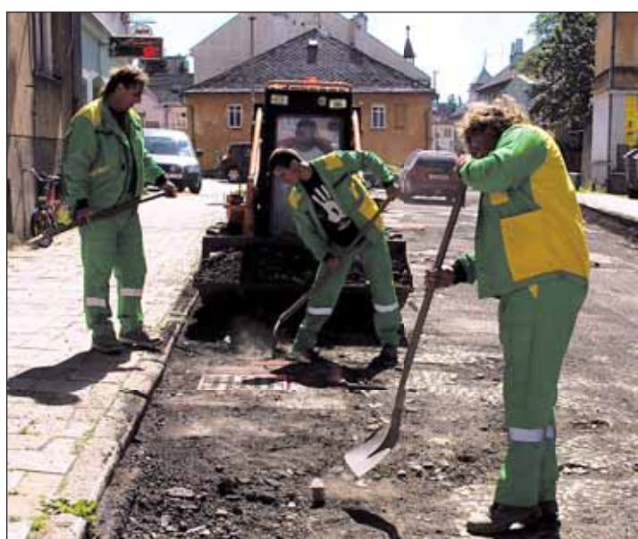
Rozsáhlé zásahy v ulici Požárníků zahrnují opravu kanalizace, vodovodu a výměnu teplovodů k propojení kotelen. Práce začaly minulý týden, v ulici bude nový povrch i chodníky. Foto: -dd-
