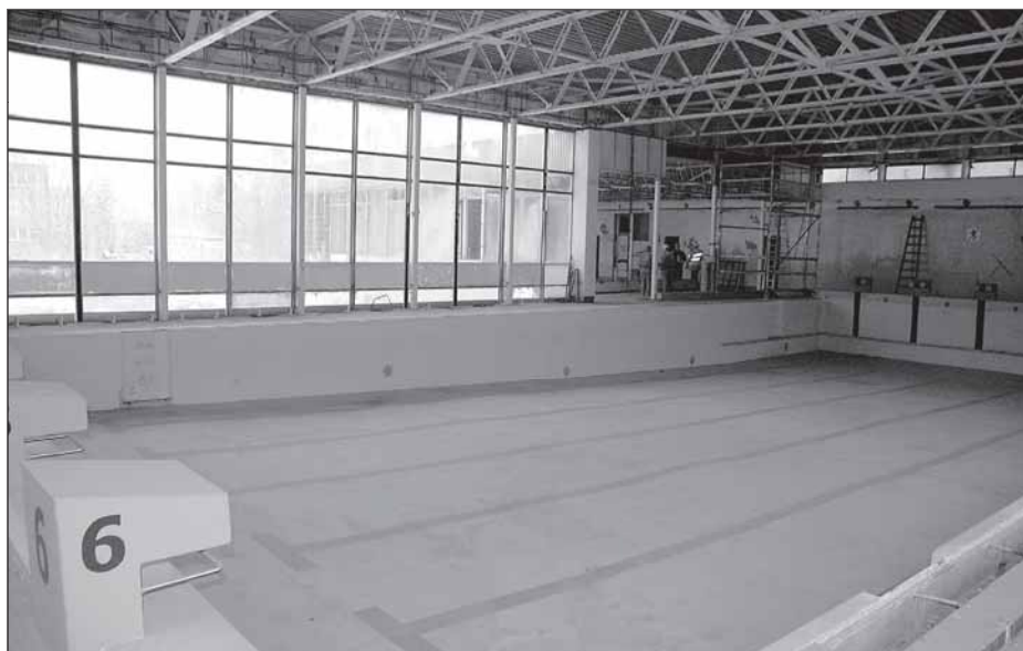
Bazénové vany bez vody a interiér bývalého baru Ponorka (vpravo).
