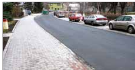
Ulice Na Nábřeží po rekonstrukci.
