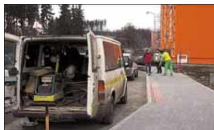
Budování zastávek MHD v Květné ulici.
