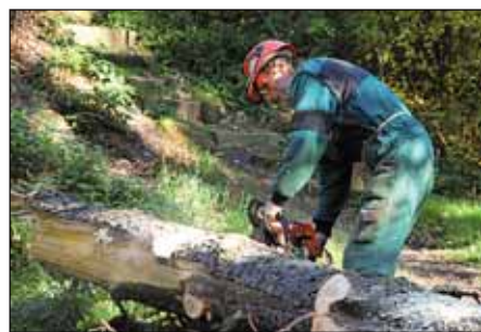
Práce na obnově městského parku.
