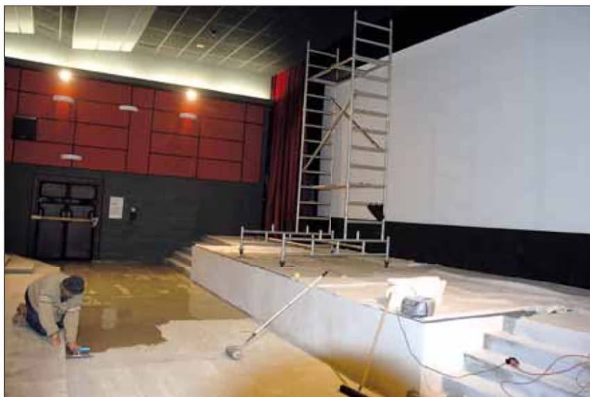
Kompletní rekonstrukce sálů v kině je hotova. Obnovené promítání ve velkém sálu začne v pondělí 2. března. Foto: Jiří Ondrášek
