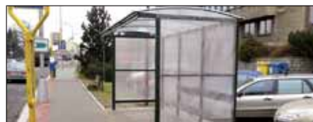
Přístřešky chrání před nepřízní počasí.
