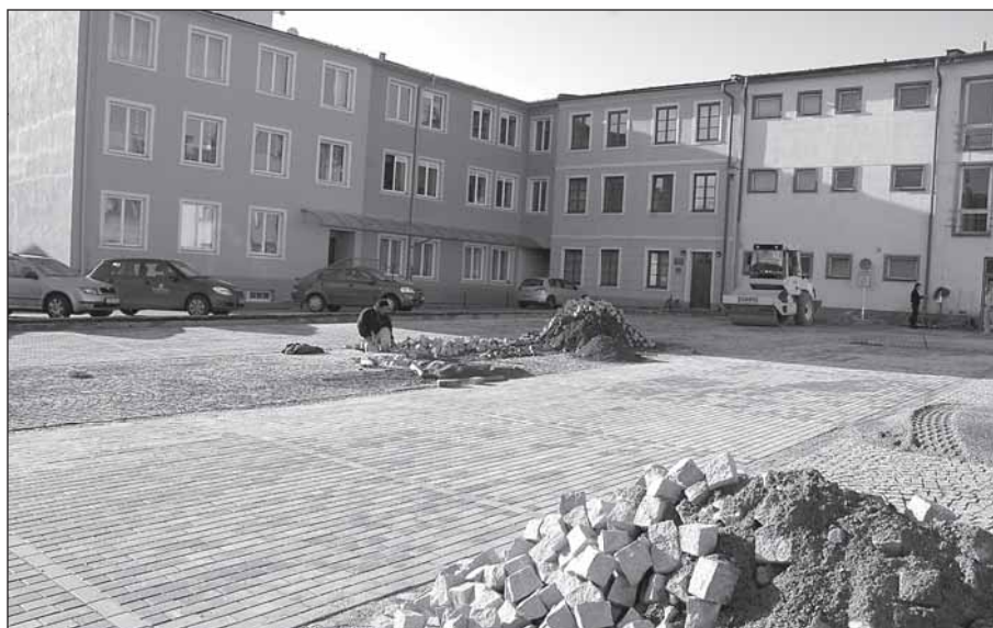
Partyzánská ulice, v prostoru za bývalou radnicí v centru města, nabízí nové parkoviště, které plynule navazuje na historické jádro. Foto: -dd-
