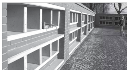
Část nového pohřebiště je už hotova.
