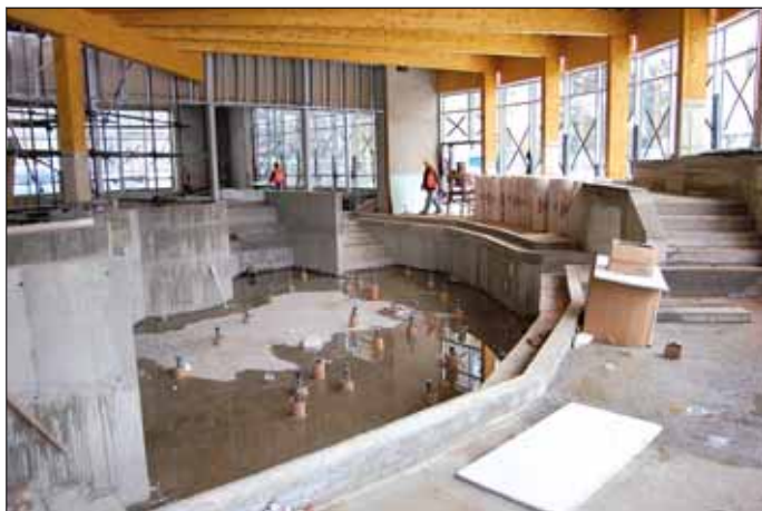
Průběžný stav rekonstruovaného bazénu, pohled na část s průplavem ven. Foto: Michal Kafura
