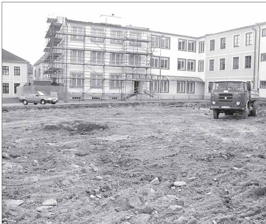
Za bývalou radnicí v centru města se začíná budovat moderní parkoviště. Foto: -dd-
